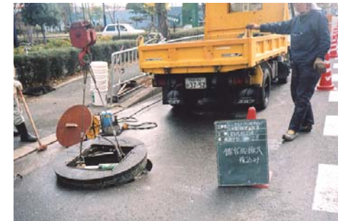
切割後用起重機起吊。
