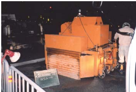
施工時用圍欄遮住，防止切渣飛濺，並消除噪音。
